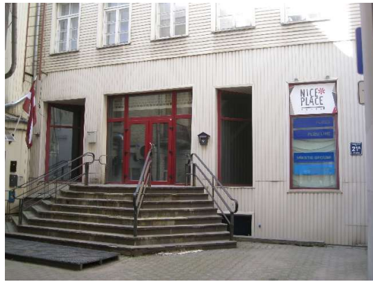
Skats uz vērtējamo objektu
