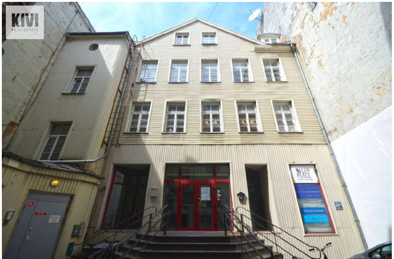
1. attēls. Administratīvā ēka Krišjāņa Barona ielā 21A, Rīgā
