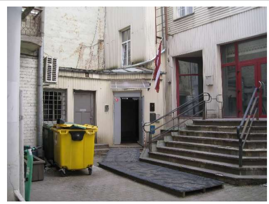
Skats uz vērtējamo objektu
