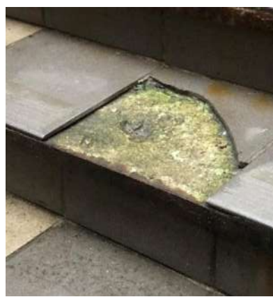
4.10.1.5. attēls. Pakāpiena bojājums – paaugstināts mitruma līmenis
