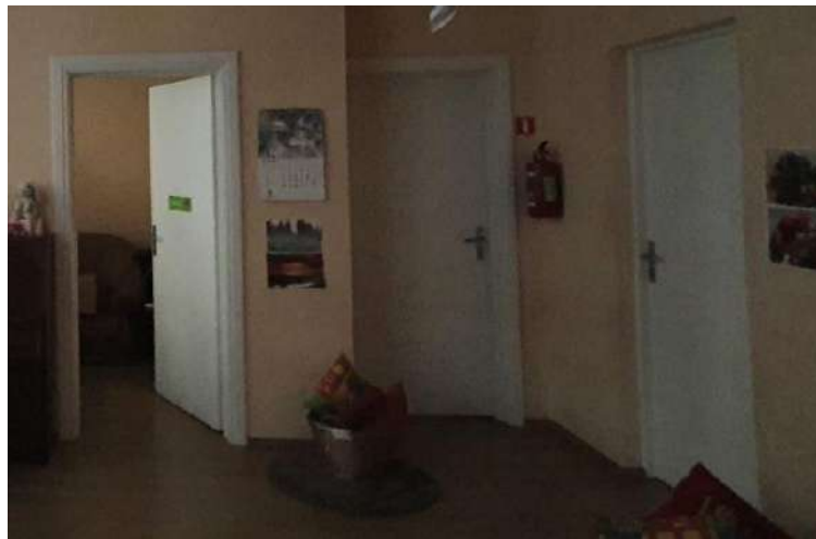
4.13.2.6. attēls. Koka iekšdurvis – paneļu tipa
