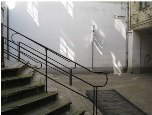
Skats uz vērtējamo objektu
