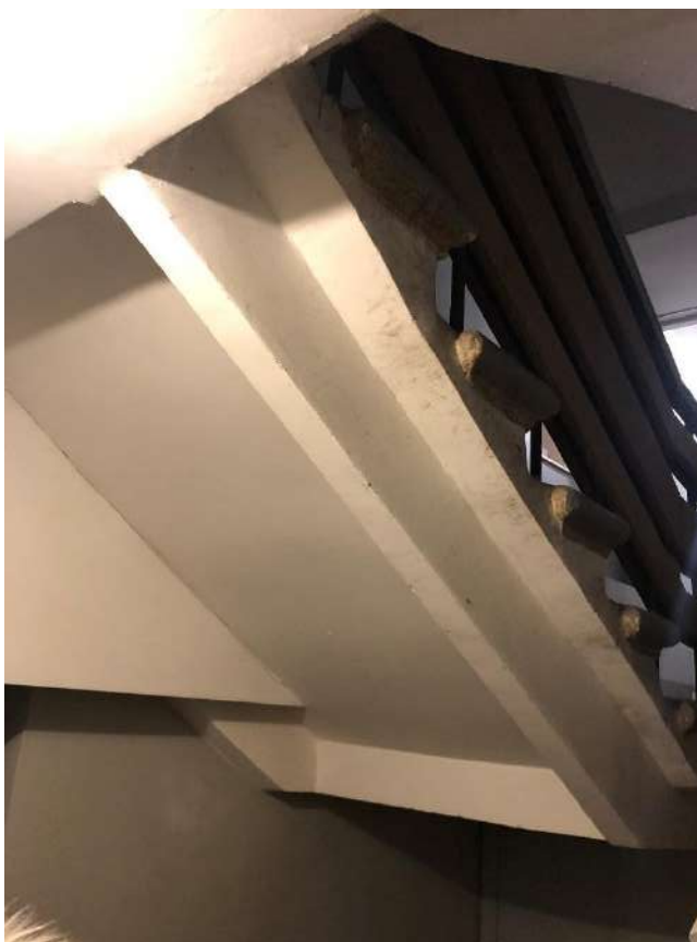
4.10.1.12. attēls. Kāpņu Nr. 3 sijas
