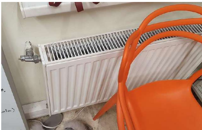
5.5.1.7.attēls. Tērauda radiatoram noskrūvēts termostāts
