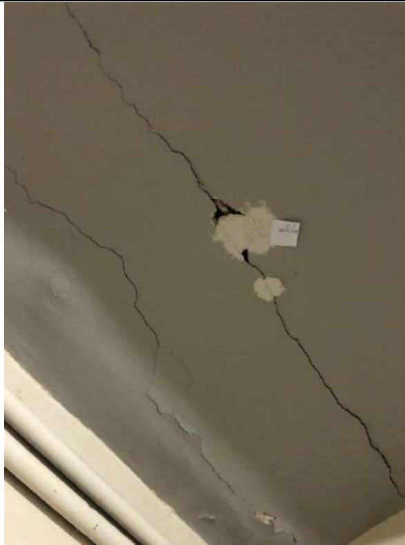
4.6.1.9 attēls. Plaisas pārseguma konstrukcijā, uzlikta kontrolmarka
