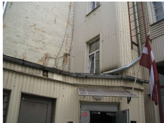
Ēkas pagalma puses fasādes
