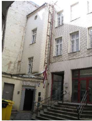
Skats uz vērtējamo objektu
