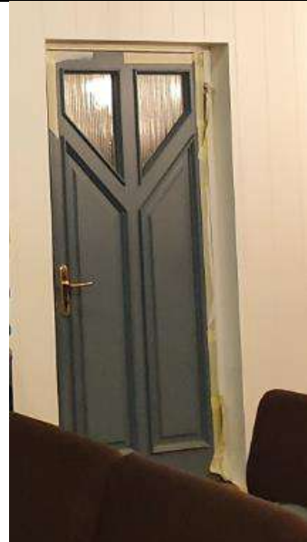
4.13.2.5. attēls. Koka iekšdurvis – pildīņu tipa
