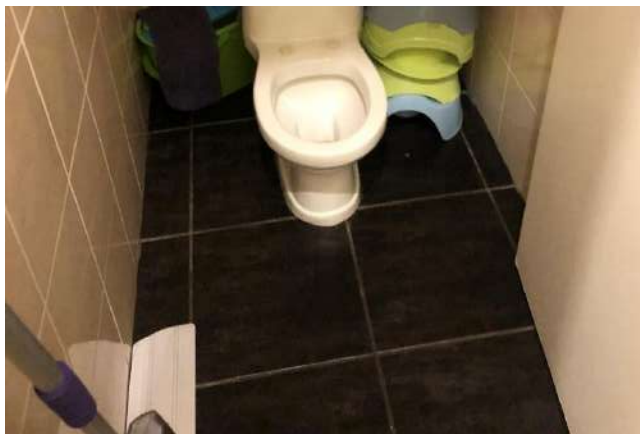
4.12.1.3. attēls. Flīžu grīdas segums – 2. stāvs
