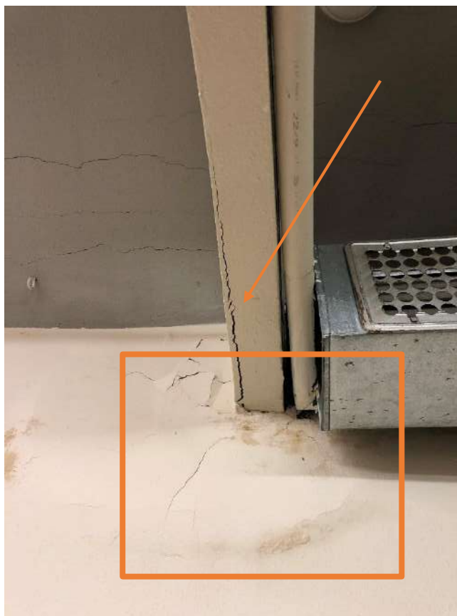
4.6.1.6 attēls. Plaisa pārseguma metāla sijā, sijas balstvietas bojājums
