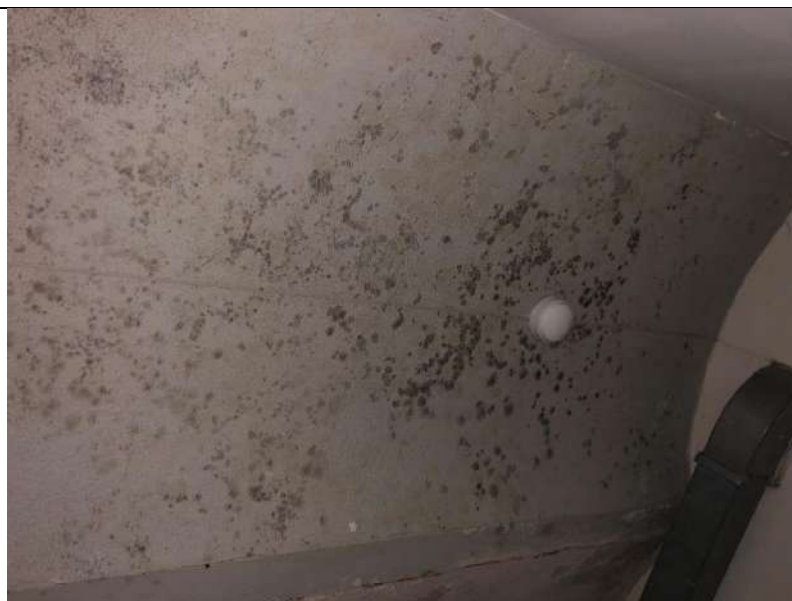
4.6.1.11 attēls. Mitruma piesātinājums – pelējums
