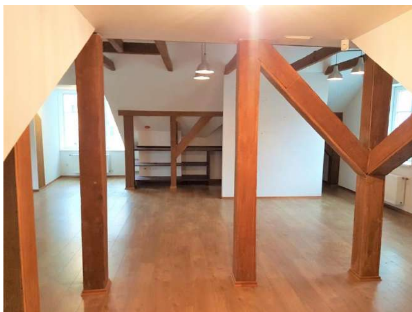
4.3.1.6. attēls. Kolonnas ēkas 4. stāvā
