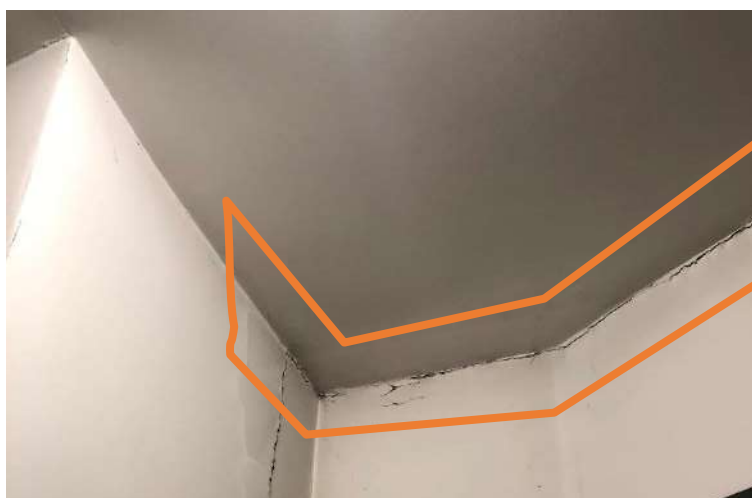
4.6.2.2. attēls. Plaisa pārseguma un sienas sadurvietā (1. stāvs, telpa Nr. 1 (901))
