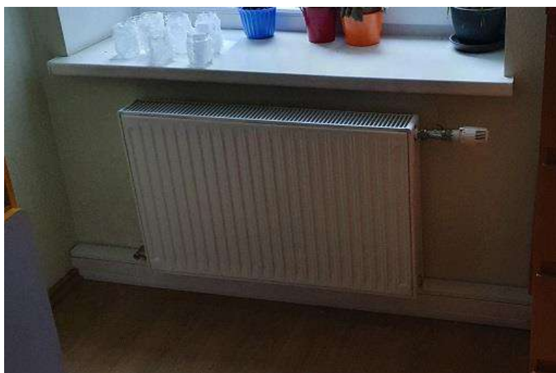
5.5.1.3.attēls. Tērauda radiators ar termostātu
