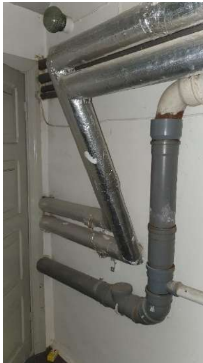
5.1.2.1. attēls. Kanalizācijas tīkls pagrabā, pāreja no ķeta uz plastmasas caurulēm, revīzija.
