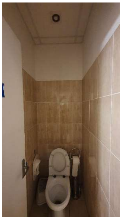
4.18.1.3. attēls. Flīzes, krāsots apmetums, piekārtie griesti – 3. stāvs
