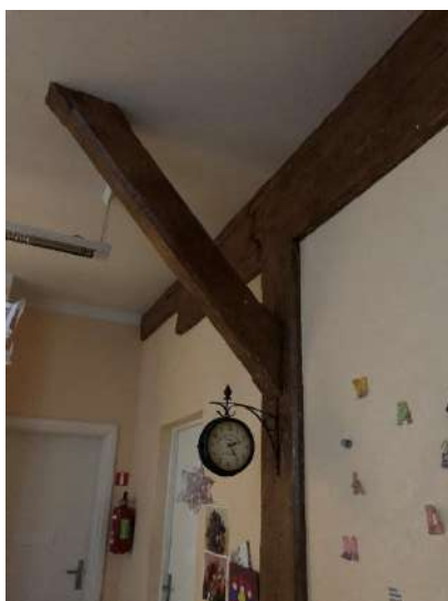
4.3.1.4. attēls. Kolonna ēkas 2. stāvā
