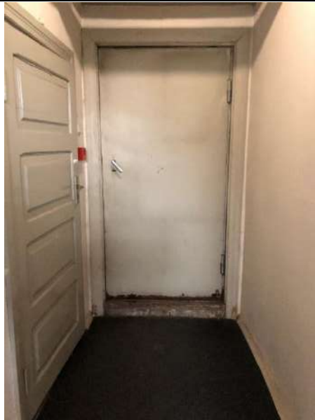
4.13.2.4. attēls. Koka iekšdurvis – pildīņu un paneļu tipa
