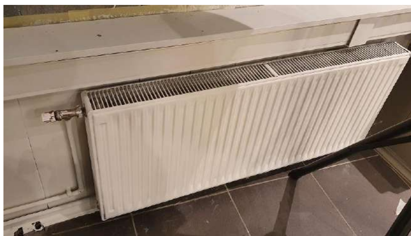
5.5.1.2.attēls. Tērauda radiators ar ventili
