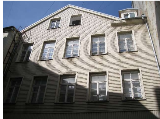
Skats uz vērtējamo objektu
