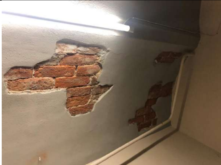
4.6.1.3. attēls. Atsejts pārseguma ķieģeļu mūris (telpa Nr. 12)
