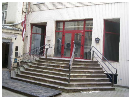
Skats uz vērtējamo objektu
