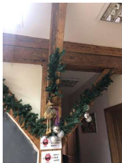
4.3.1.5. attēls. Kolonna ēkas 3. stāvā
